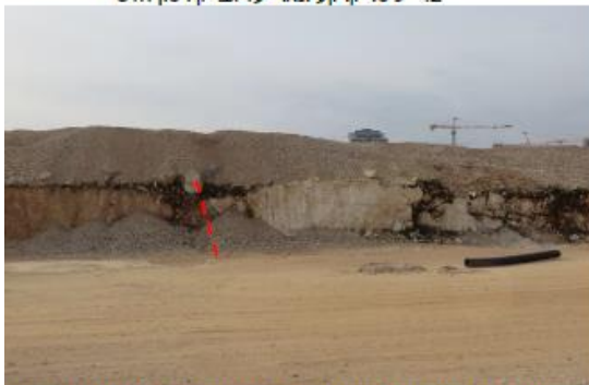
4. מעבר בין סלע חלש קרטוני לחזק גירי (יתכן חצר משמאל או סדק עם תנועה אנכית עליו) אזור בלוי עם חדירות חרסית מימין
