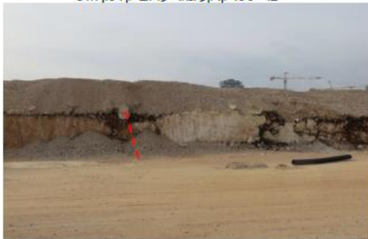
4. מעבר בין סלע חלש קרטוני לחזק גירי (יתכן חצר משמאל או סדק עם תמעה אנכית עליו) אזור בלוי עם חדירות חרסית מימין
